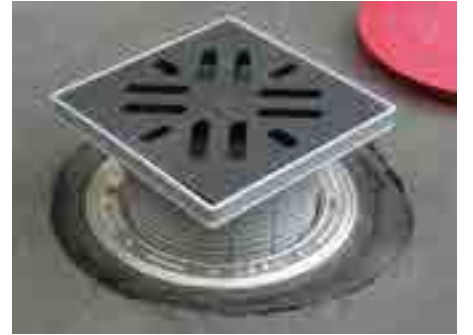
6. Yapı korumasını indirin, yükseltme parçasını kısaltarak yüzeyin seviyesine getirin
